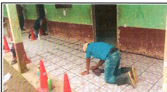
Foto 4: Foto 4 : Avance de la colocacion de piso en el corredor de la escuela.
