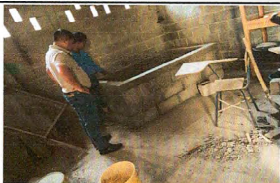
Foto1: Foto 1: Avance de la construccion del polleton
