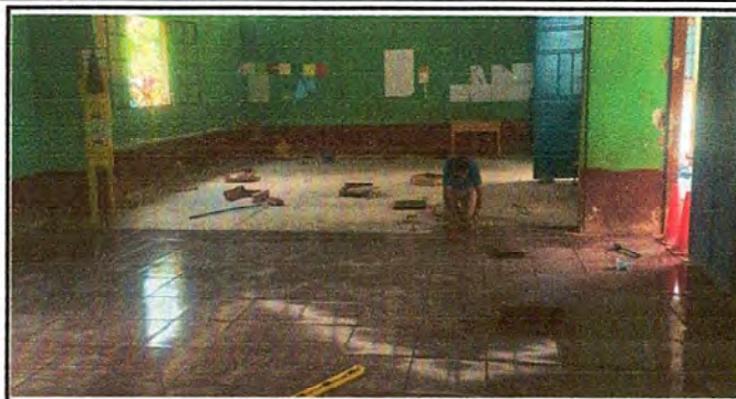
Foto 2: Foto 2: avance de la colocación de pisos azulejos
