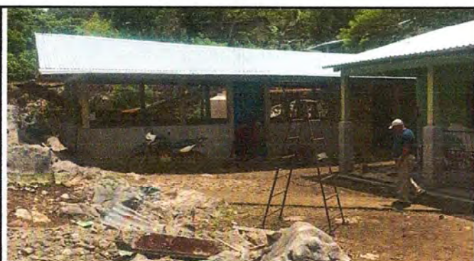
Foto 3: Foto 3: Avance en la colocacion de las puertas de las aulas
